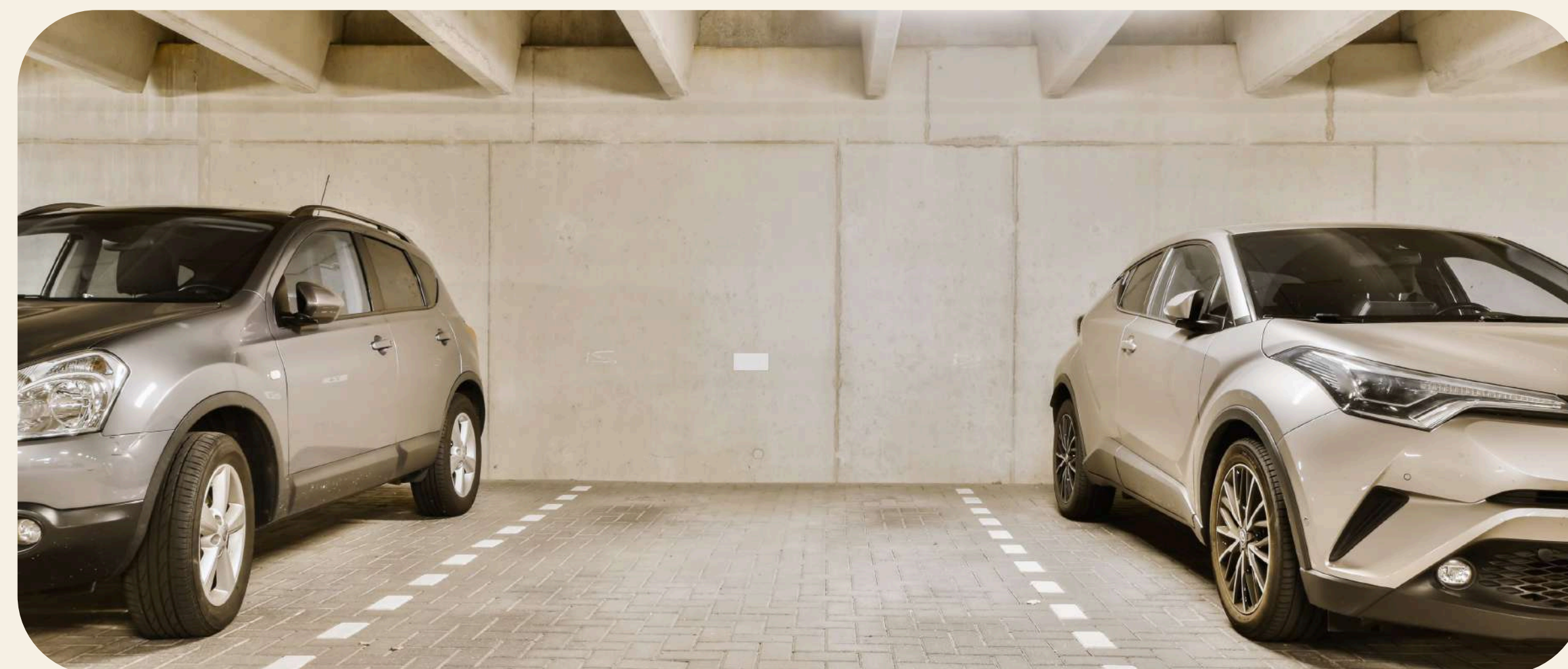
Garaje con preinstalación eléctrica
